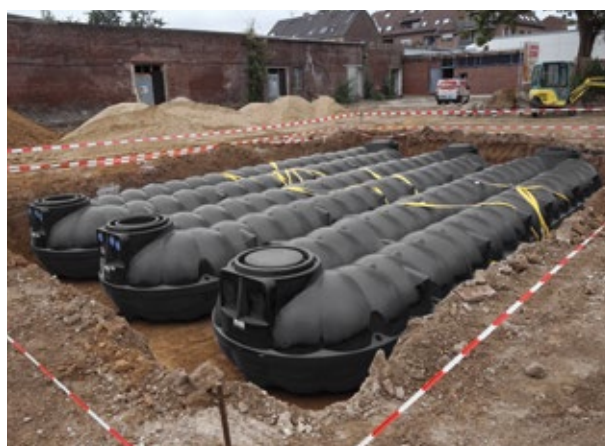
Installation av NEO-tank for regnvannsoppsamling 3 x 20 000 l
