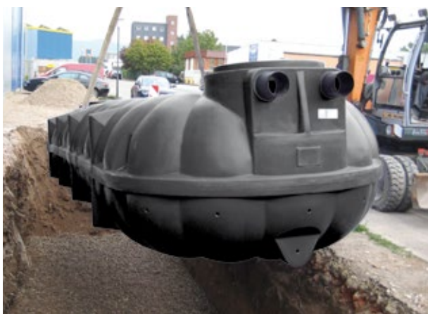
Installering av NEO-tank for filtrering 10 000 l
